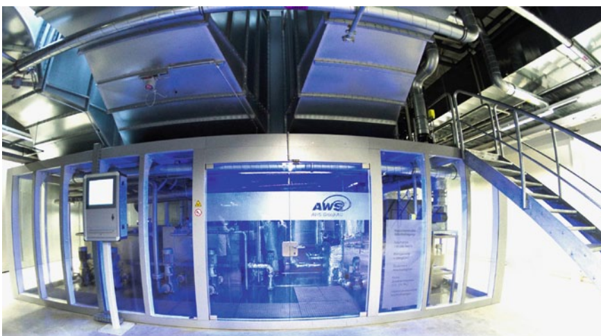
Bild 1: Zur Reinigung der Spritzkabinenabluft hat ein Automobilhersteller das neu entwickelte Verfahren in seine Produktionsprozesse integriert
