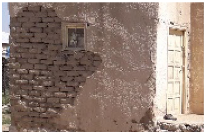
(d) Running bond masonry wall
