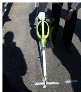
Pouring the epoxy
