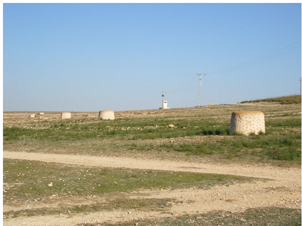
Fig. 6 Shafts of the Pulpillo qanat (Yecla, Murcia)
