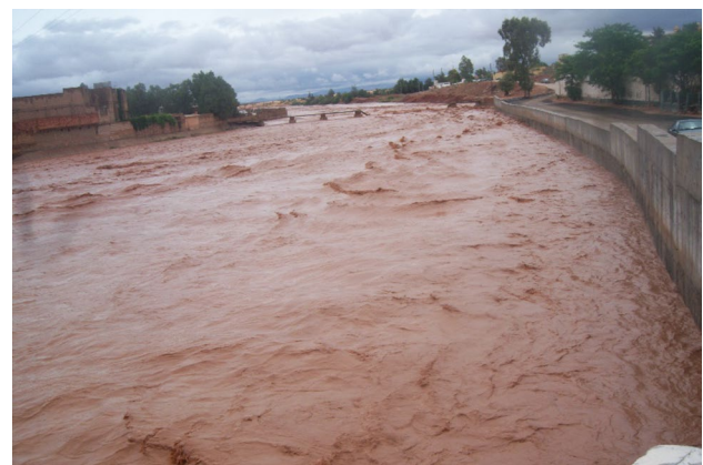
Fig. 12 Retaining walls in wadi Ain Sefra
