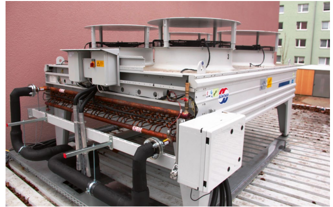
► Abb. 2 / BHKW-Heizzentrale (links) und Luft/Sole-Tisch-Wärmetauscher auf dem neuen Müllhäuschen an der Stirnseite des Gebäudes Ersinger Straße 4 (rechtes Bild)
