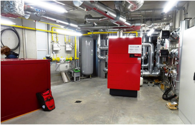
► Abb. 2 / BHKW-Heizzentrale (links) und Luft/Sole-Tisch-Wärmetauscher auf dem neuen Müllhäuschen an der Stirnseite des Gebäudes Ersinger Straße 4 (rechtes Bild)
