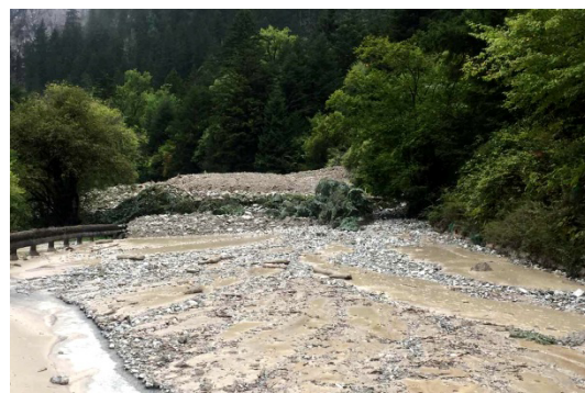
(d) Debris flow blocked the road
