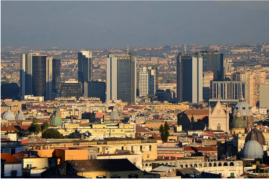
Fig. 3 Centro Direzionale, Naples. Source: https://commons.wikimedia.org/wiki/File:Centro_Direzionale_di_Napoli.jpg
