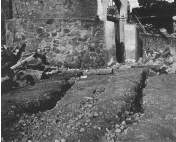
Fig. 19 Ground cracks at marina of Reggio Calabria (Società Fotografica Italiana 1909)
