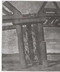
Damage in the bridge (J. Milne)
