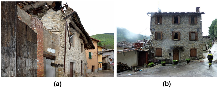
Fig. 16 Timber roofs: a Castelsantangelo sul Nera, via B. Vittazzi; b Arquata del Tronto, Pescara del Tronto
