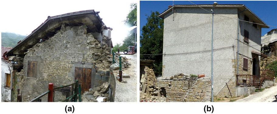
Fig. 15 Replaced reinforced concrete roofs: a Arquata del Tronto, Pescara del Tronto; b Amatrice, San Tomasso
