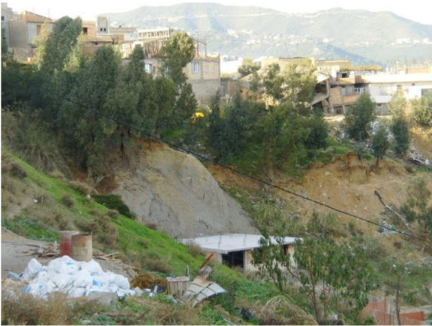
Fig. 21 Terrassement effectué en aval des constructions
