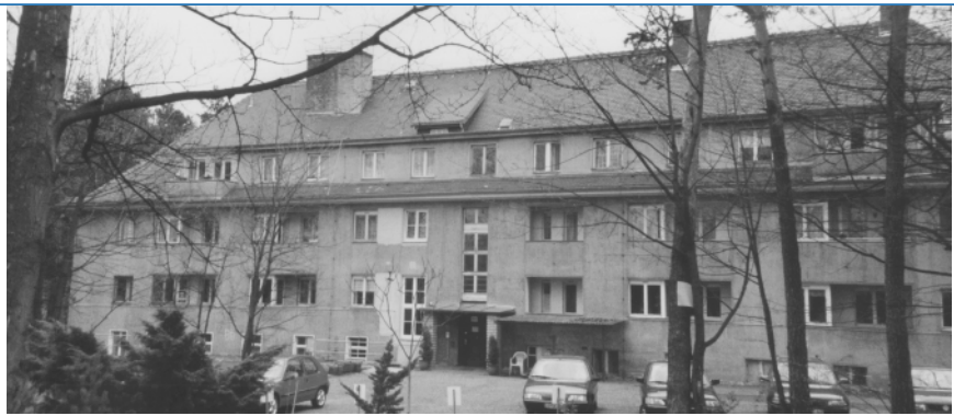
Abb. 2 ▲ Institut für Rheumatologie Dresden in der Königsbrücker Landstraße
