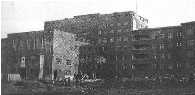
Abb. 3 ▲ Vorderansicht des späteren „Albert-Servais-Haus“ 1945 Nordfront mit Vorbau und Hauptportal, das größte Gebäude der Städtischen Krankenanstalten Aachen. Hier waren initial Chirurgie, Orthopädie, Naturheilkunde und HNO-Klinik untergebracht, Bettenzahl 302, später war im Erdgeschoss rechts ein Teil der Urologischen Klinik untergebracht (Repro: Institut für Geschichte, Theorie u. Ethik in der Medizin, Aachen. Mit freundlicher Genehmigung)
