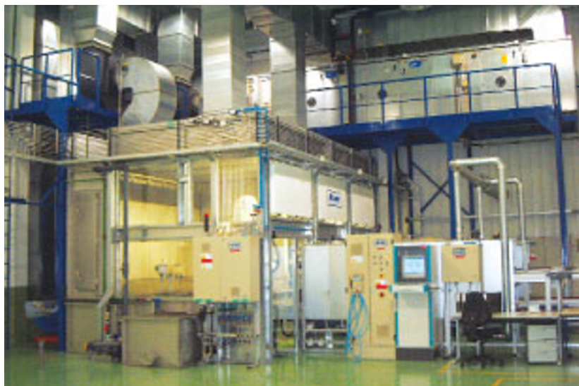
Blick auf die komplett eingehauste Lackierkabine mit der 2-K-Anlage, Steuer-schrank und PC sowie dem Aufgabebereich
