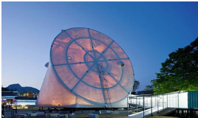
Fig. 7 Prada transformer exterior
