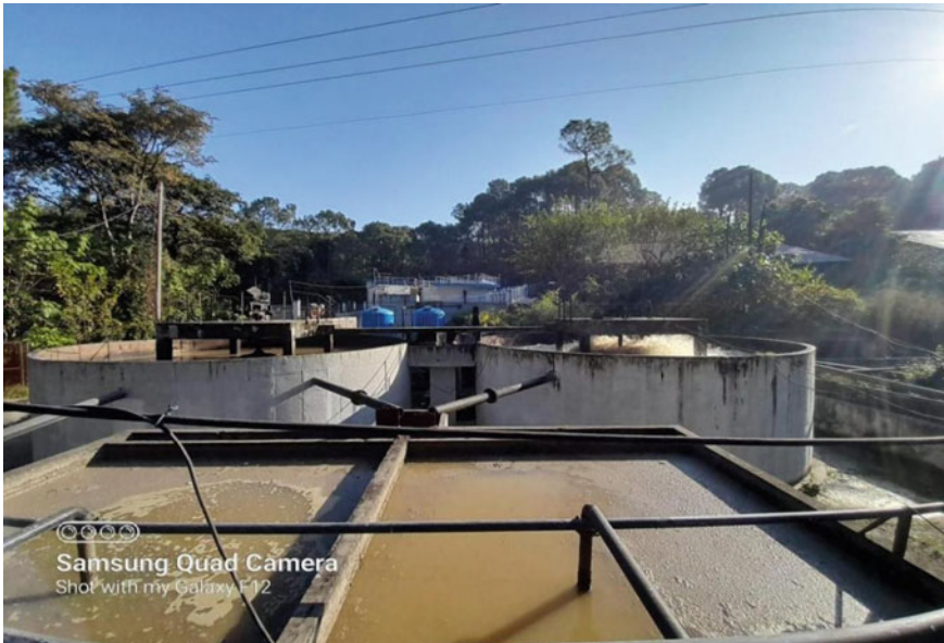
Fig. 2 NIT Hamirpur WWTP site
