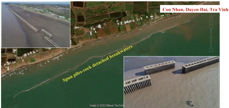
Fig. 18 Spun piles–rock detached breakwater in Con Nhan, Tra Vinh
