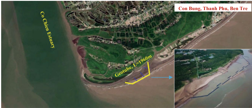
Fig. 13 Geotube breakwater in Con Bung, Ben Tre
