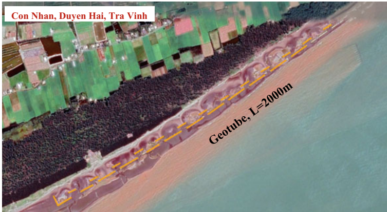
Fig. 12 Geotube breakwater system in Con Nhan, Tra Vinh
