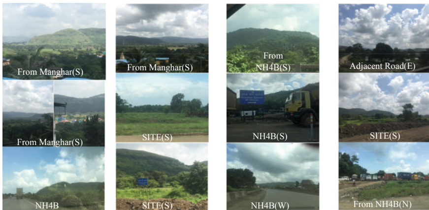
Fig. 2 Visual survey of site
