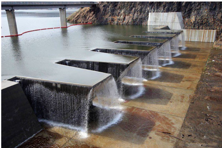
Fig. 8.4 Trapezoidal Piano Key Weir (Kumar et al. 2021)
