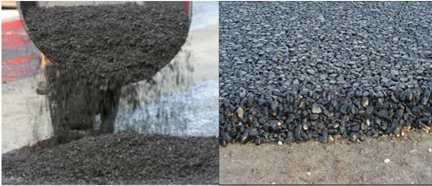
Fig. 1 Hot mix Asphalt production
