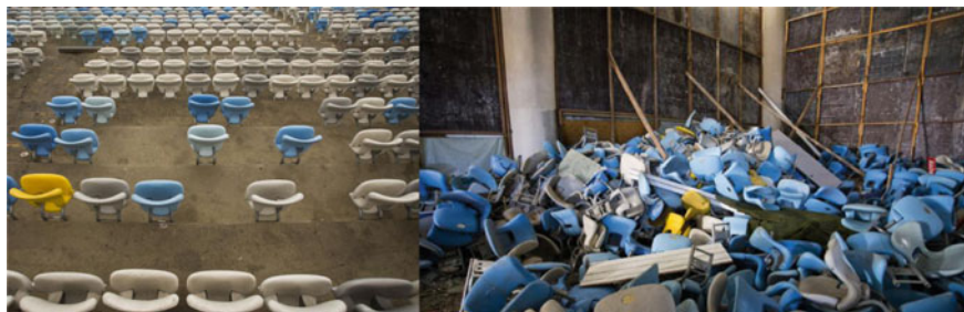
Fig. 12 State of despair for the Maracanã Stadium, Rio [28]
