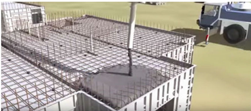
Fig. 3 Pouring of concrete
