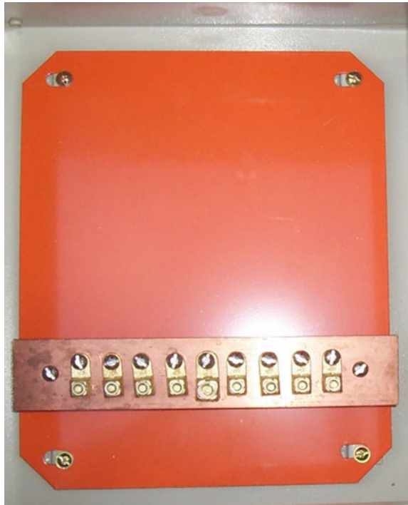
Fig. 11 Example of a Main Equipotentialization Busbar (MEB)
