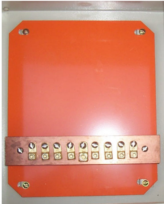
Fig. 11 Example of a Main Equipotentialization Busbar (MEB)
