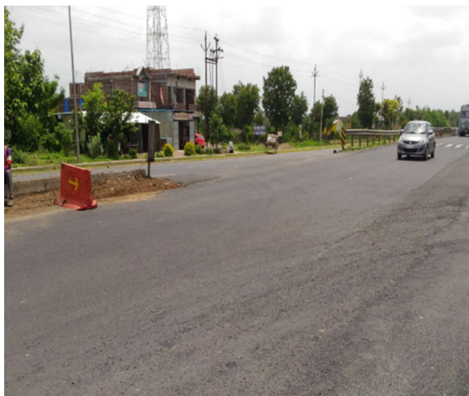
Fig. 10 18 km chainage (median opening)
