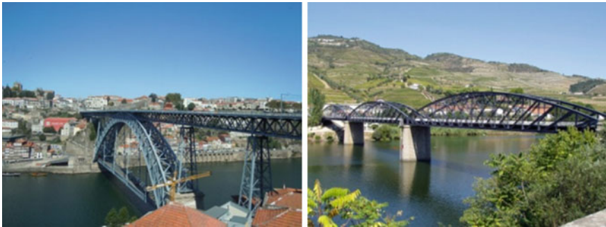
Fig. 6 D. Luis (Porto) and Pinhão (Pinhão) bridges
