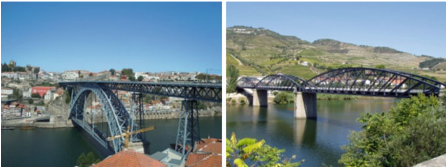
Fig. 6 D. Luis (Porto) and Pinhão (Pinhão) bridges
