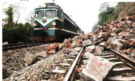
(d) Perimeter Intrusion stones
