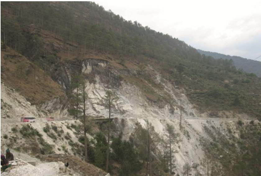
Fig. 1. Tangni landslide on NH-58
