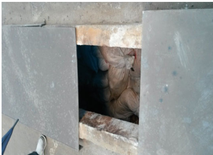
Fig. 3 Slag warehouse in Jiangsu
