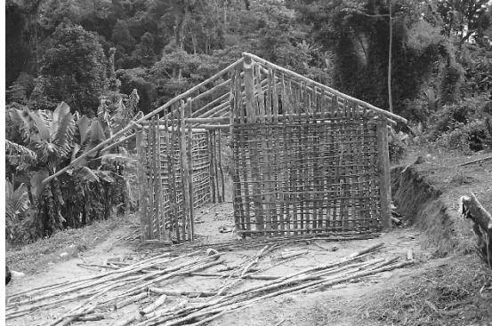
Fig. 6.15 Guarani house under construction, Área Indígena Guarani do Itaóca, 2001
