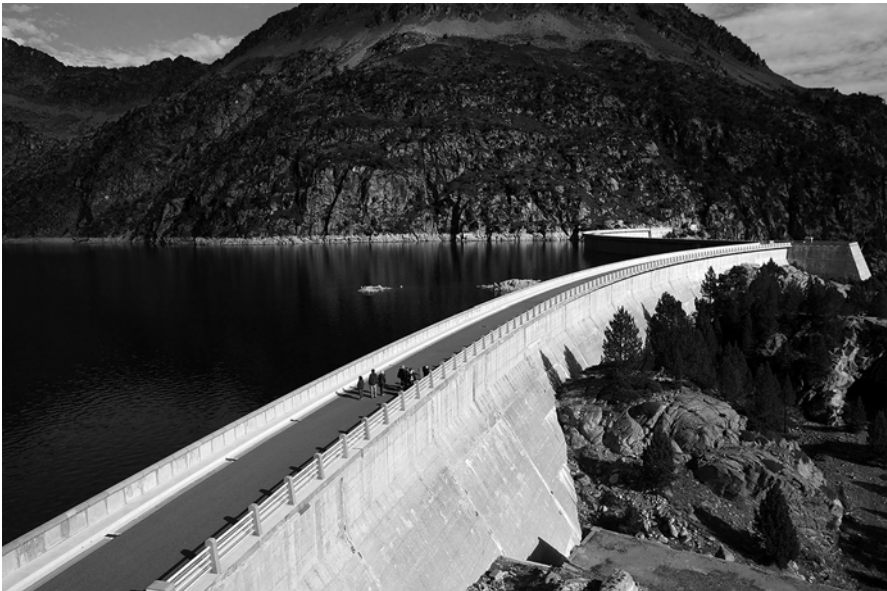
Fig. 8.2 The Cap-de-Long Dam in the granite massif of Néouvielle (Hautes-Pyrénées) (Photo S. Briffaud)
