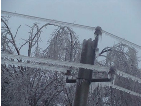
Fig. 4.2 Ice accretion on electric power line ( Source : Ministry of Civil Defence, Emergencies and Disaster Relief of Russian Federation. Copyright: http://www.mchs.gov.ru/ . Copyright «МЧС России», 2010. Все права на материалы, находящиеся на сайте, охраняются в соответствии с законодательством РФ. При полном или частичном использовании материалов ссылка на mchs.gov.ru обязательна [Copyright “Ministry of Civil Defence, Emergencies and Disaster Relief of Russian Federation”, 2010. The rights to all the materials on this web site are protected in accordance with the Russian legislation. If using the materials, the reference to the mchs.gov.ru is required])
