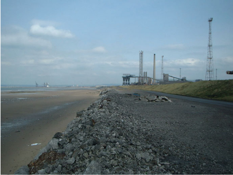
Fig. 17.8 Blast furnace slag revetment
