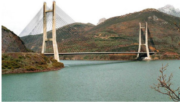
Fig. 7.13 “Barrios de Luna” Bridge
