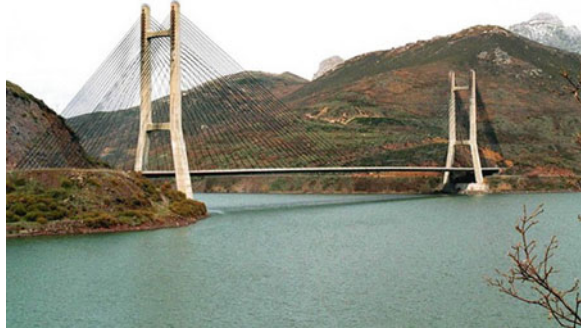
Fig. 7.13 “Barrios de Luna” Bridge
