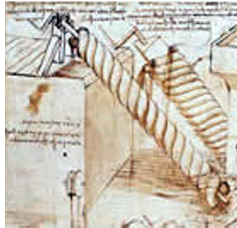
Fig. 2. Screw pump of Leonardo da Vinci.
