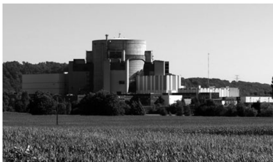
Fig. 7 Veduta panoramica della centrale Superphenix, chiusa nel 1997 (Foto: Yann Forget)
