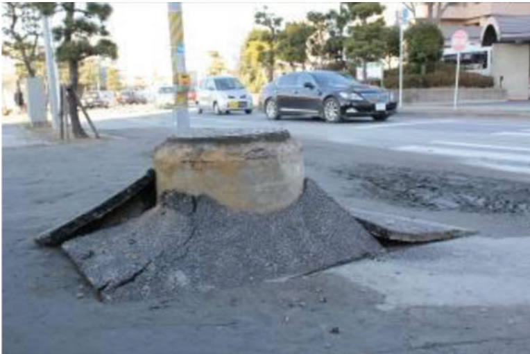
Fig. 10.13 Protruding manhole
