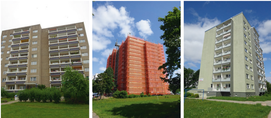
Abb. 7.1 Drei der vier Wohnblöcke im Quartier „Titaniaweg“ in unterschiedlichen Phasen des Sanierungsprozesses. (Fotos: J. Pöbneck)
