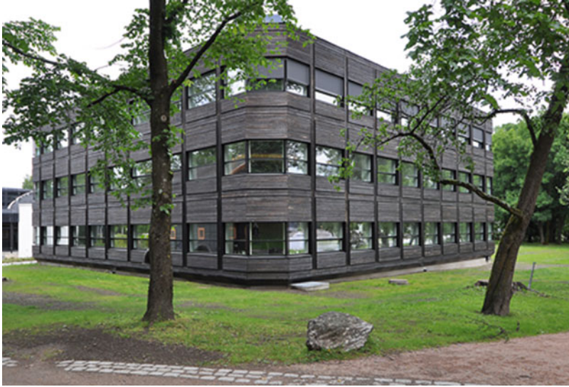
Fig. 7 One of the office blocks of Powerhouse Kj rbo. Photo: Byggenytt.no
