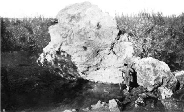
Fig. 6 Rockfalls along the railway line in Favazzina (Società Fotografica Italiana 1909)
