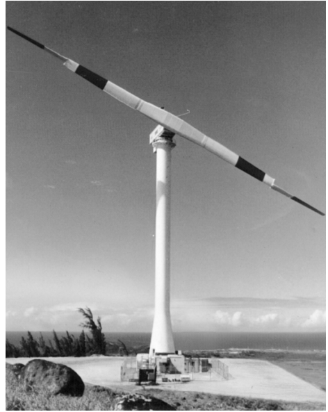
Fig. 2.21. MOD-5, (rotor diameter 97 m, 3200 kW), BOEING (USA), 1987
