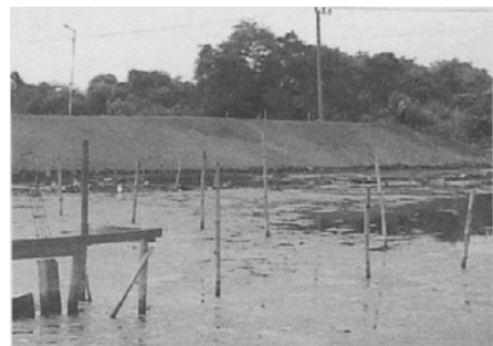
(d) Trial embankment at final condition
