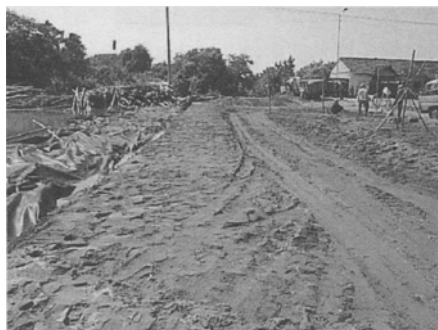
(c) Embankment fill
