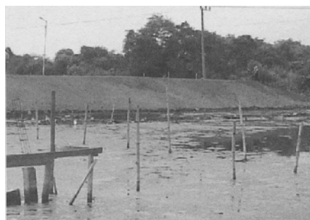
(d) Trial embankment at final condition
