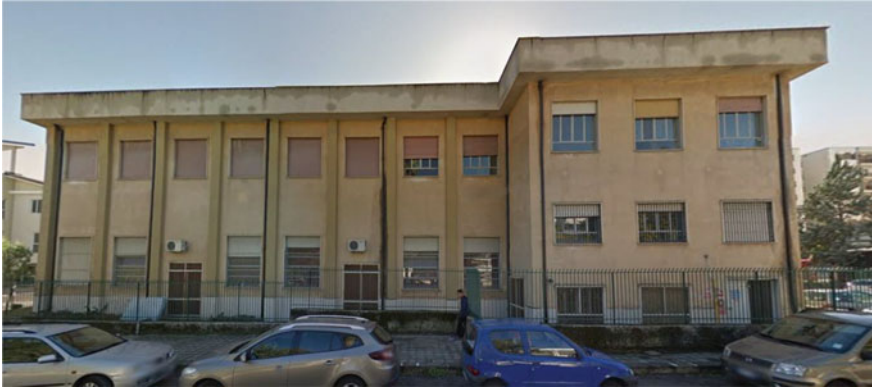
Fig. 1 The Auditorium of the I.T.I. “A. Monaco”
