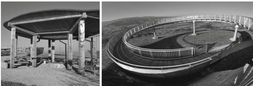
Fig. 2. Observation platform in Wola Krogulecka near Stary Sącz, photo by A. Klimkowski, ( http://www.starostwo.nowy-sacz.pl/pl/wiezewidokowe )
