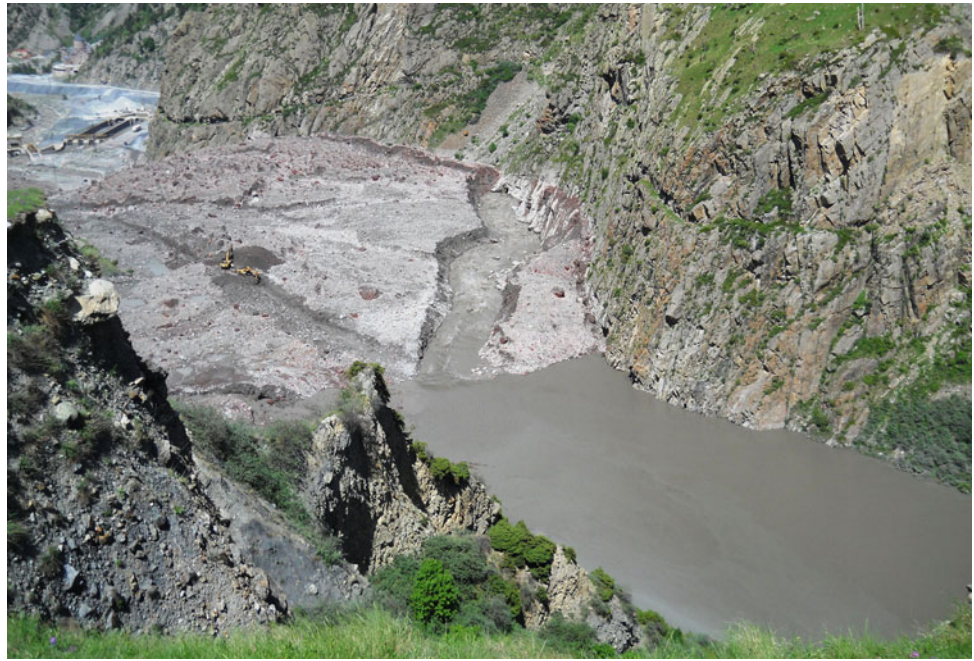
Fig. 1 Debrisflow disaster in Dariali (Kazbegi, Georgia)
