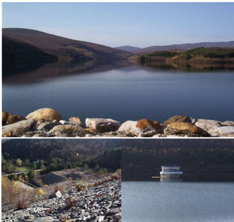
Fig. 3 Water reservoir Bukovec II (photo: M. Zeleňáková)
