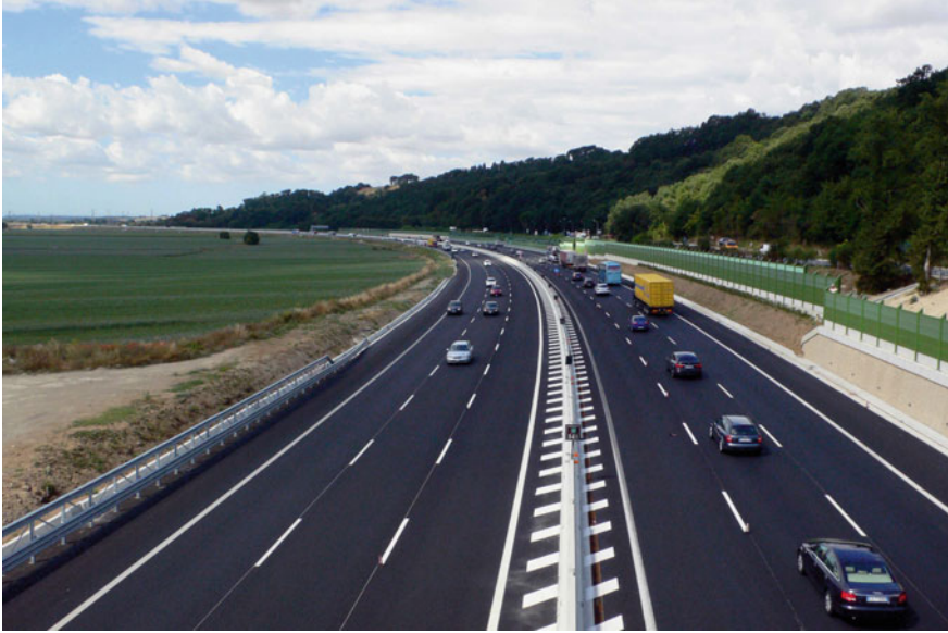
Fig. 1.1 A road stretch in A1 freeway, close to Rome, Italy (courtesy of Autostrade per l'Italia SpA, photo from Archivio Videofotografico Autostrade per l'Italia)
